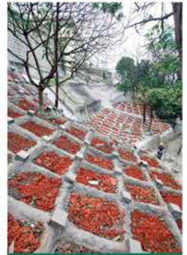
多項護坡工程已完工。
