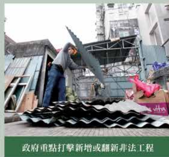
工作人員清拆天台屋
