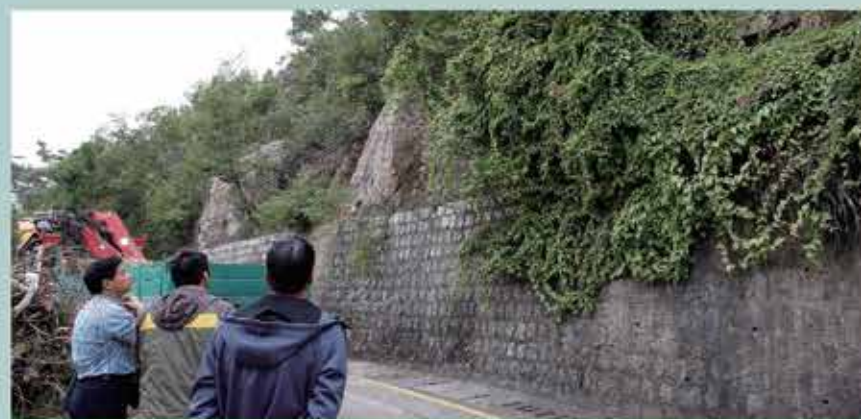
斜坡安全工作小組會對全澳斜坡作恆常的巡查工作
