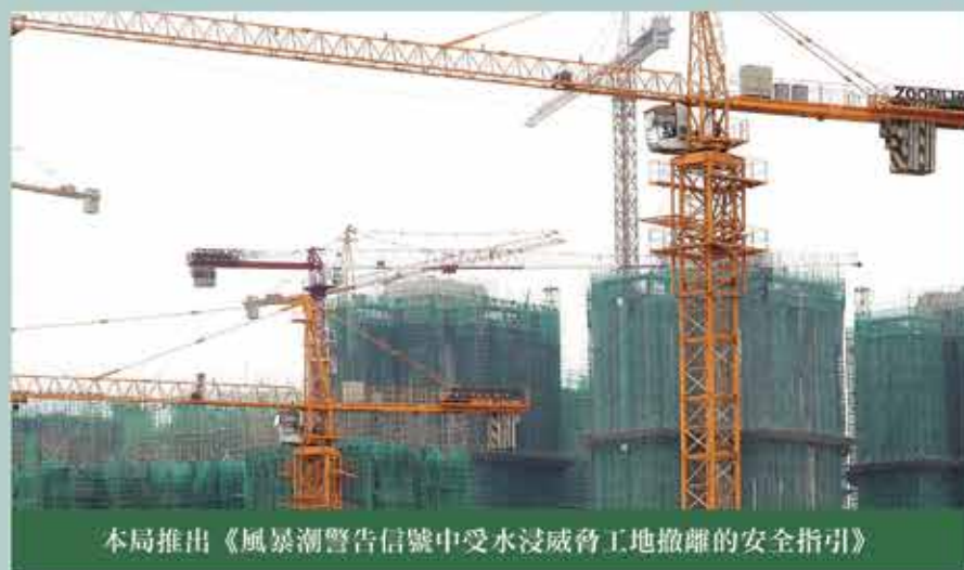
進入風季，工程承建商應特別留意工地安全
