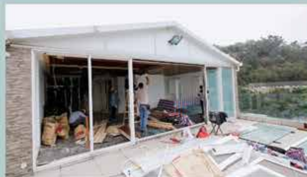
工人正在清拆一宗位於雅廉訪大馬路個案的“天台屋”
