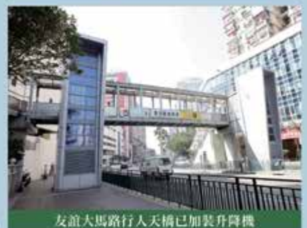
三角花園行人天橋落腳點將加裝升降機
