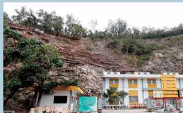
正進行加固工程的氹仔嘉樂底總督馬路斜坡
