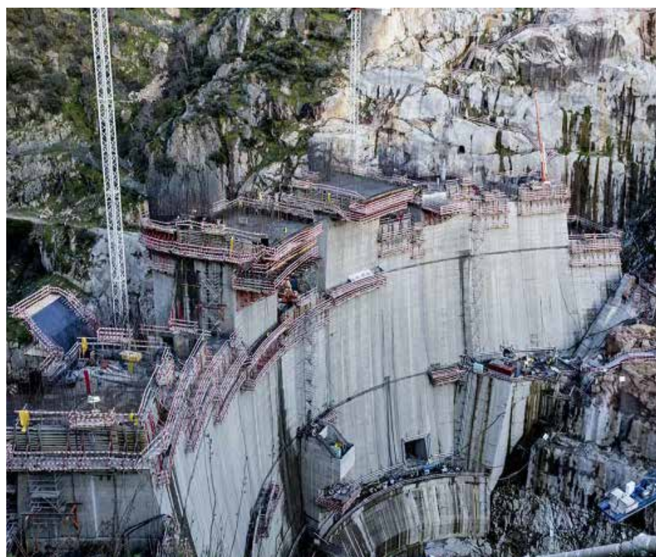
卡庫洛·卡巴薩水電站工程
