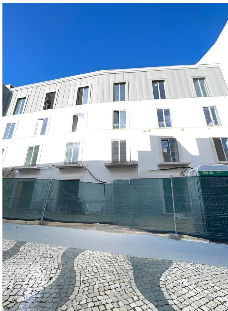
位於Cacilhas的新公寓正在最後的施工階段 Edifício residencial em Cacilhas em final de construção.
